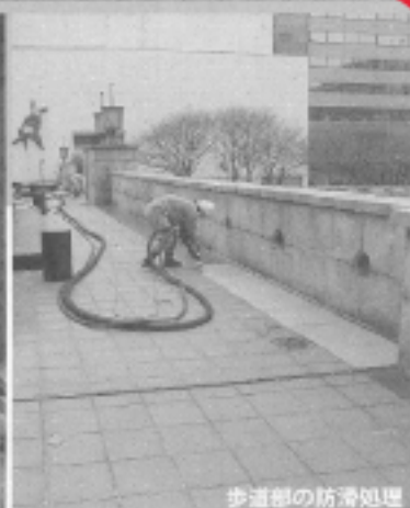
橋梁・既存塗膜除去及び劣化調整
