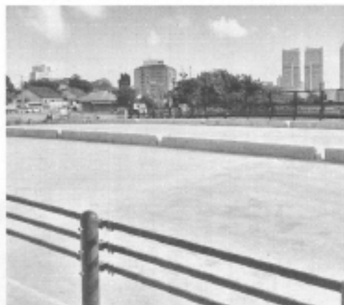
橋を上から(写真はいずれも日鉄エンジニアリング提供)
