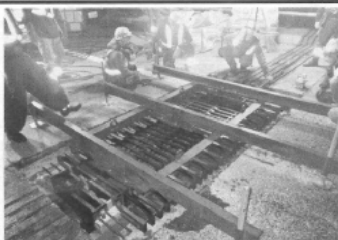
取替工事が完成
