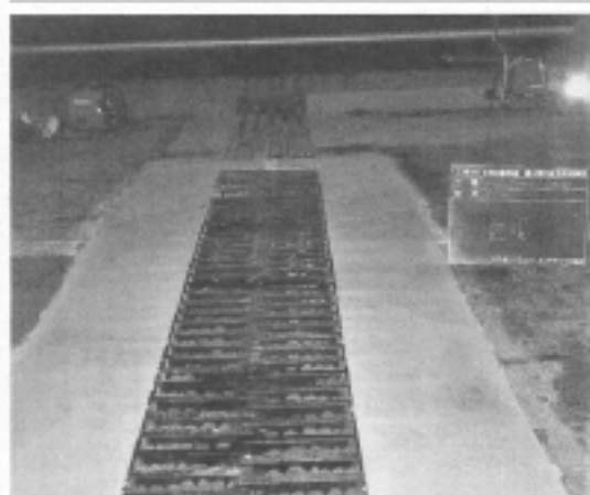
工事の様子(写真はいずれもクリテック工業提供)
