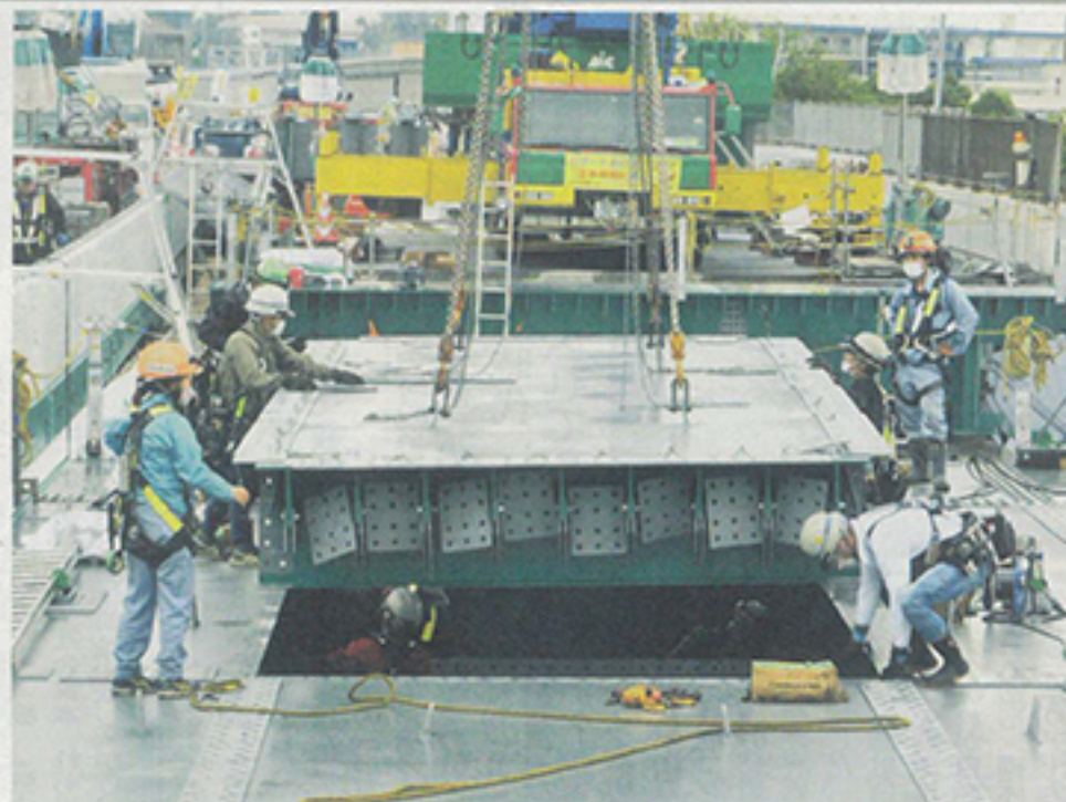
新しいブロックが設置済の床版に取り付けられた
