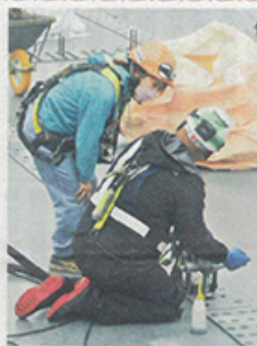
新しいブロックが設置済の床版に取り付けられた
